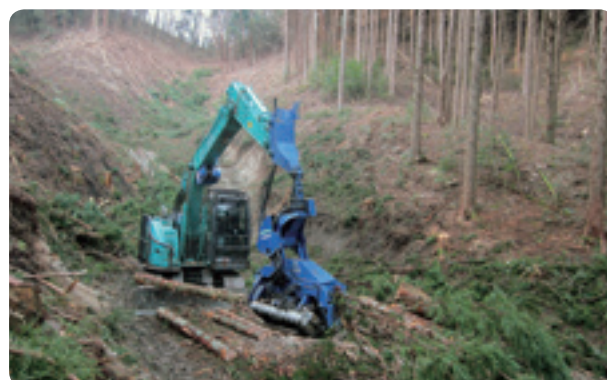
高性能林業機械による造材
