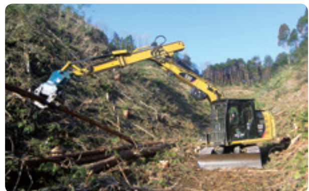
ロングリーチグラップルによる集材作業
