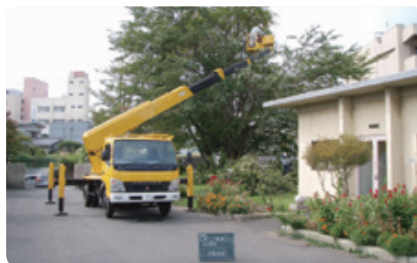
高所作業車による伐採作業
