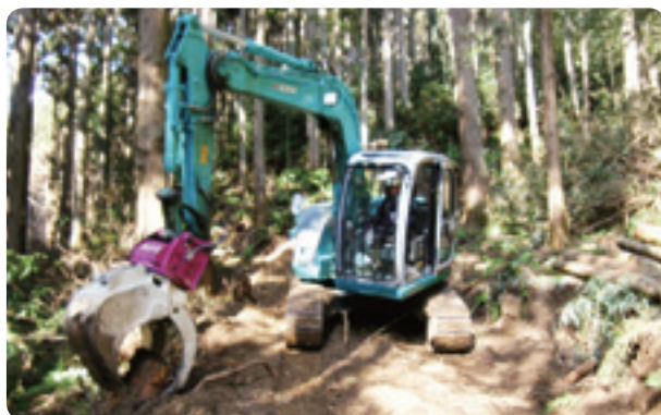
間伐作業道の開設
