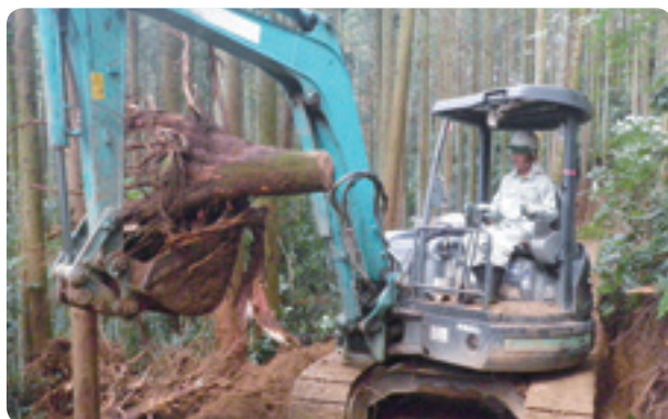
作業道の作設
