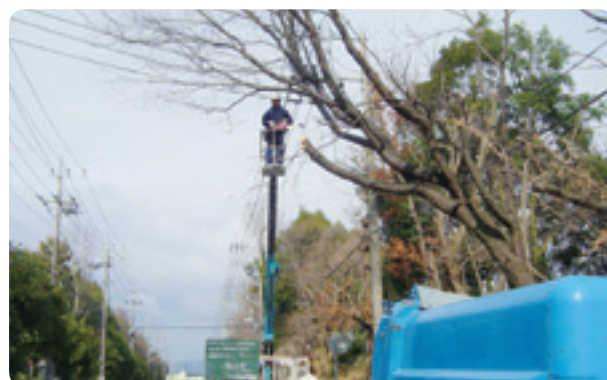
高所の伐採作業
