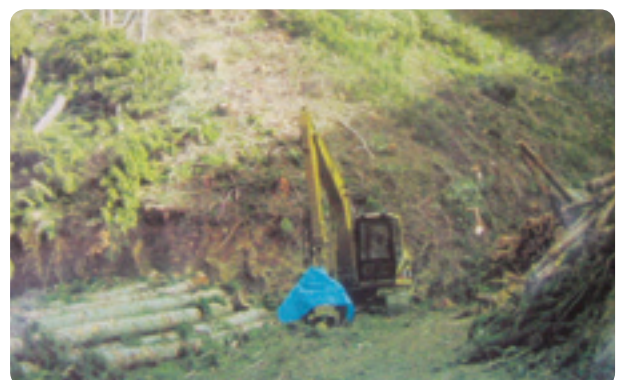
伐採作業現場
